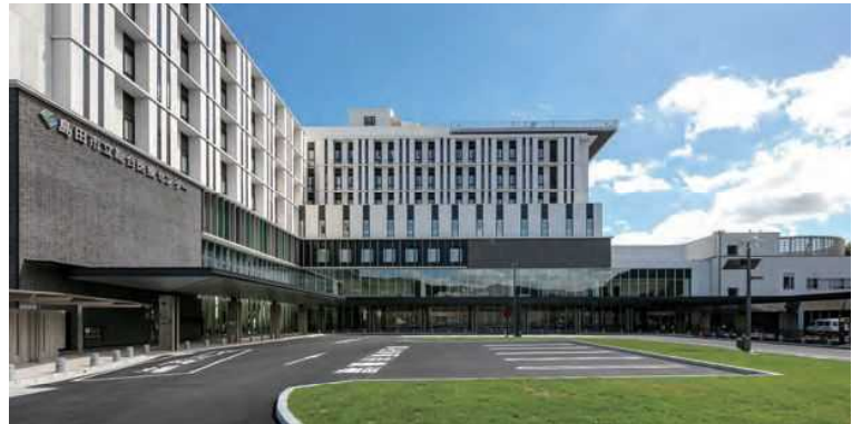
(駐車場整備終了、令和5年3月グランドオープン)
