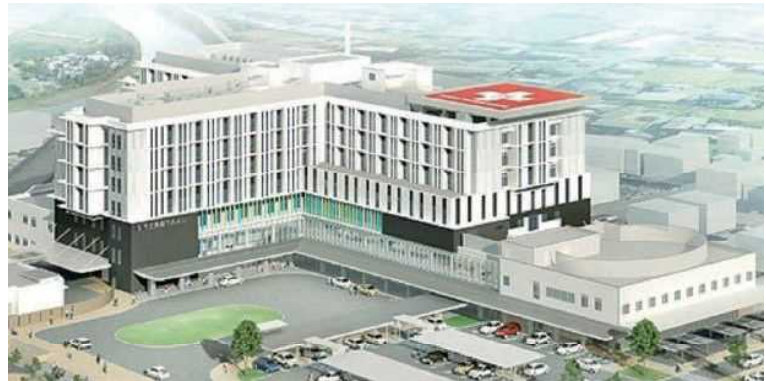
(旧病院解体・駐車場整備後、令和5年3月グランドオープン予定)
